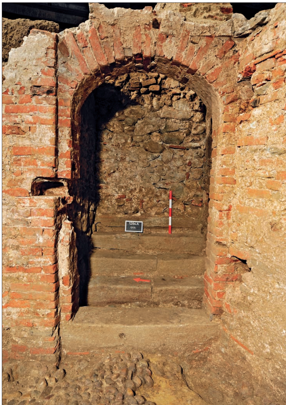
Hinter dem südöstlichen Eingang sind die Treppenstufen sowie die kurz vor dem Bau der Schlossscheune eingebaute Quermauer zu erkennen. Ansicht von Westen.
