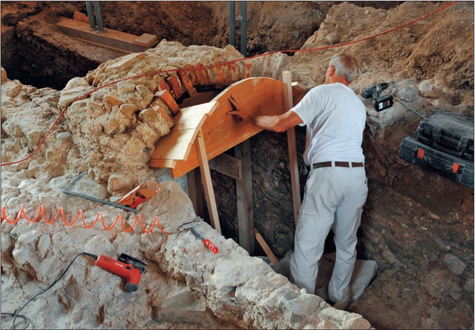
Der untere, gut erhaltene Teil des Gewölbes über der Kellertreppe wird vom Spezialisten für die Restaurierung von historischem Mauerwerk, Josef Wermelinger, Alberswil, stabilisiert.
