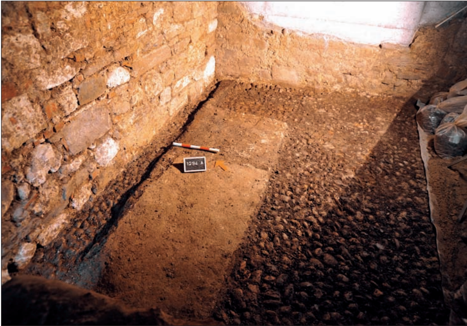
Das Fundament der Nordfassade der Schlossscheune (links) wurde direkt auf die Pflasterung des mittelalterlichen Kellers gestellt. Ansicht aus südwestlicher Richtung.
