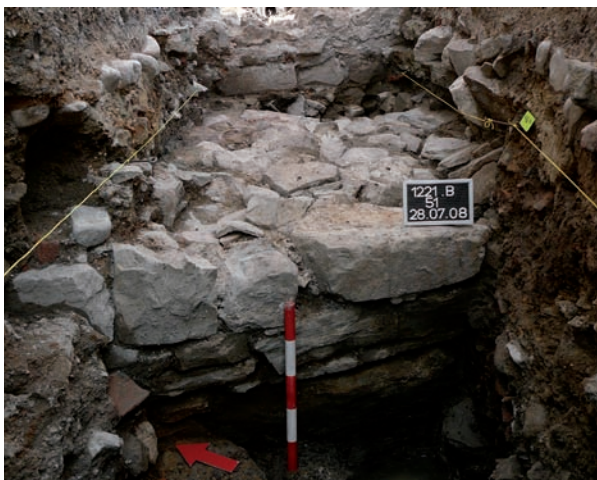
Abb. 26 Ein massiver Mauersockel am Reussufer dürfte zur Schleifmühle des Harnischers (Rüstungsschmieds) gehört haben (Haus XVIII). Die Eichenbalken, welche das Fundament trugen, wurden gemäss der dendrochronologischen Resultate nach 1460/65 geschlagen.
