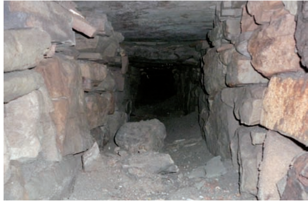
Abb. 45 Innenansicht des frühneuzeitlichen Abwasserkanals. Der Kanal ist über weite Strecken als Hohlraum unter der Platzfläche erhalten geblieben.
