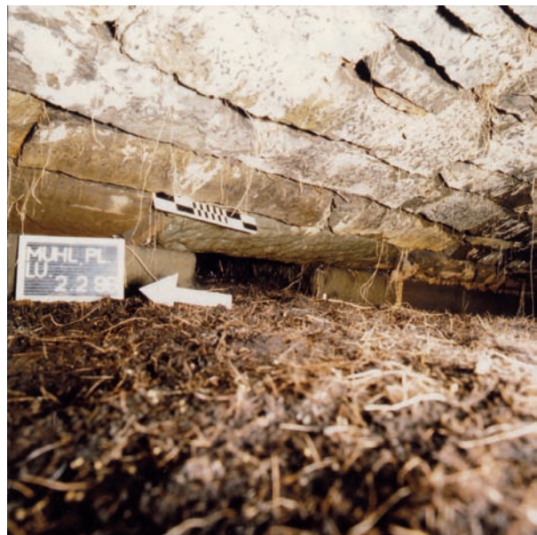
Abb. 47 Bereits 1995 konnte das südliche Ende des heute bis zum Gewölbeansatz mit Schwemmmaterial angefüllten Münzkanals dokumentiert werden. Dabei wurde eine Einmündung von Osten her festgestellt – es handelt sich, wie die Grabung 2008/09 zeigte, um die Mündung des frühneuzeitlichen Abwasserkanals.
