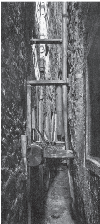
Abb. 14 Die schmalen „Ehgräben“ zwischen städtischen Liegenschaften dienen der Entsorgung von Unrat. In Luzern sind derartige Ehgräben kaum erhalten geblieben. Blick in den Ehgraben an der Zürcher Königengasse, 1939.
