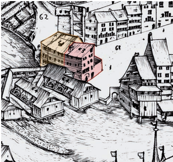
Abb. 33 Martinus Martini zeigt in seiner Stadtansicht von 1597 das wenige Jahre zuvor erbaute steinerne Harnischerhaus, dessen Fundamente bei der Grabung 2008/09 erfasst werden konnten (rot, Nr. „63“). Gleich dahinter wird 1597 die wasserbetriebene städtische Münzprägestätte eingerichtet (orange).
