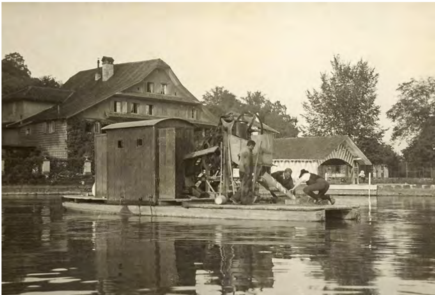
Frühe Pfahlbauforschung: Wilhelm Amrein auf dem Schwimmbagger bei Altstadt LU
