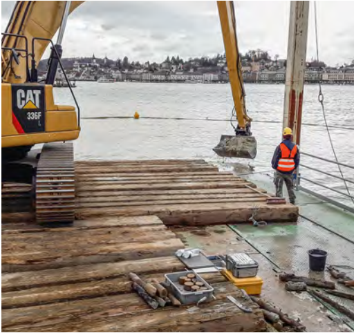
Baubegleitung auf dem Schwimmbagger: Bergung von prähistorischen Hölzern.
